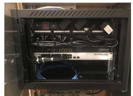
Netwerkkast, volledig afgewerkt
