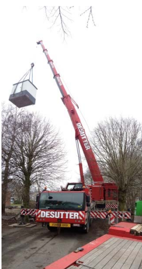
Nieuwe hoogspanningscabine word geplaatst
